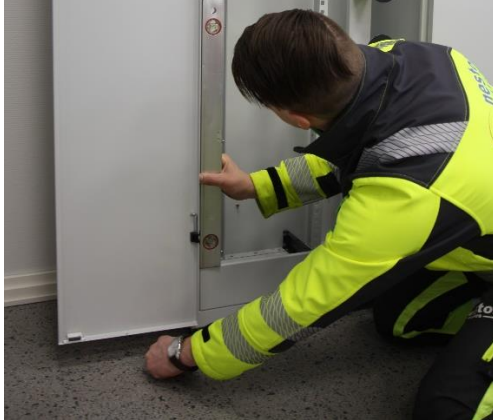
Teline asennetaan aluksi suoraan säätäen pohjassa olevia säätöjalkoja
