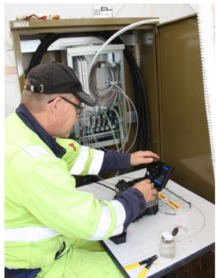
Kuva 8.4. Valokuidun jatkamista maastossa (Kuvat: Nestor Cables Oy).
