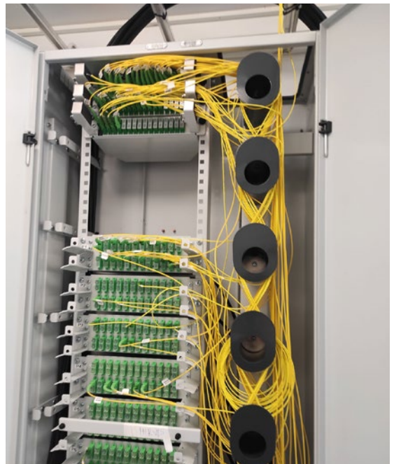
Kuva 6.7. Jaottimia sijoitettuna laitetilassa valokaapeleiden ristikytkentätelineeseen (Kuva: Televerkkopalvelut Seppo Marttila Oy).
