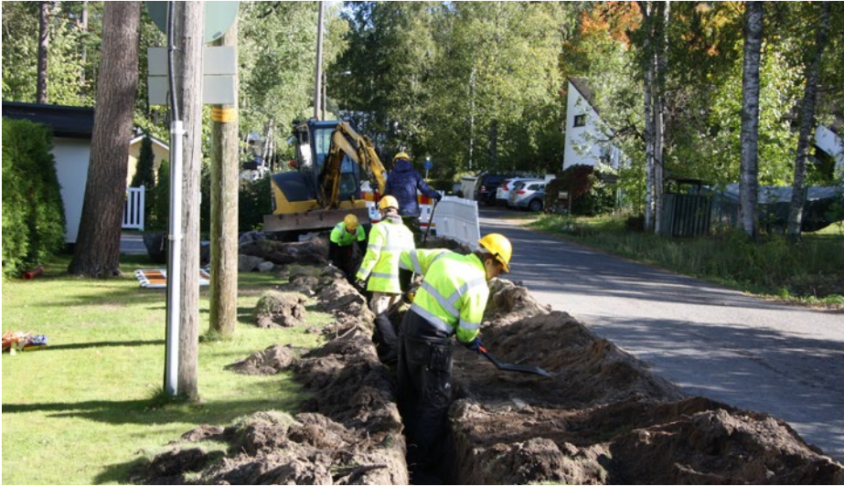
Kuva 7.9. Kaivannon viimeistelyä mikrokanavien asentamista varten (Kuva Nestor Cables Oy)
