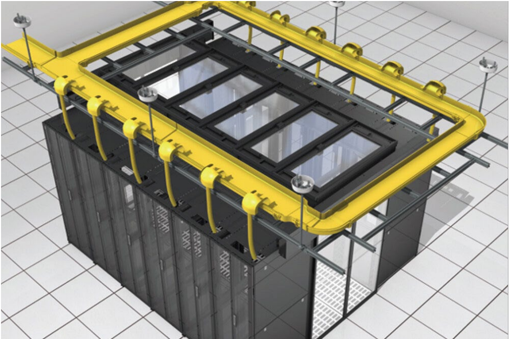
Kuva 8.17. Esimerkki kuituhyllyistä laitetilassa.
