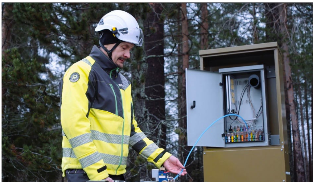
Kuva 7.12. Mikrokanavakaapelin puhallusta (Kuva: Nestor Cables Oy).
