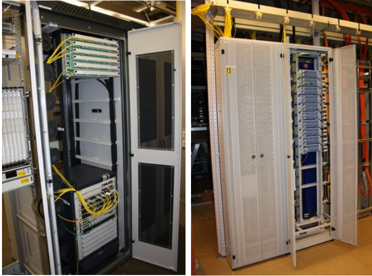
Kuva 4.23. Esimerkkejä jakamotelineistä. a) perinteinen 19 tuuman mekaniikka, b) erityisesti optista kaapelointia varten suunniteltu ja kehitetty mekaniikka (Nestor Cables Oy).
