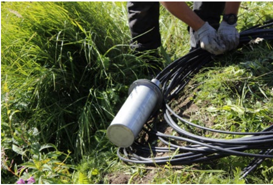
Kuva 4.28. Asennettuja ulkojatkoskoteloita (Kuvat Nestor Cables Oy).
