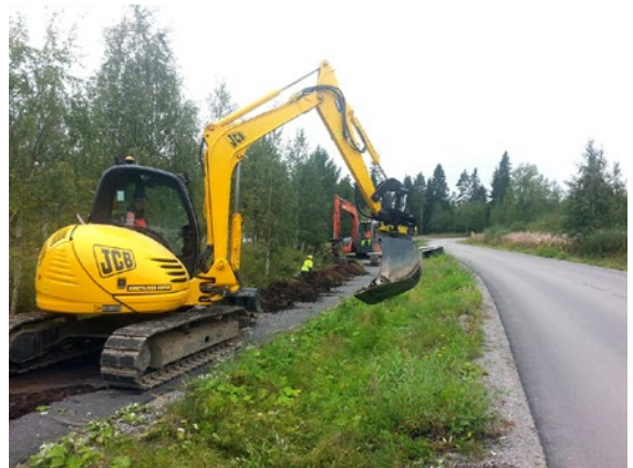
Kuva 7.13. Maakaapeleiden asennusta (Kuvat: Veljekset Toivanen Oy ja PyhäNet Oy).
