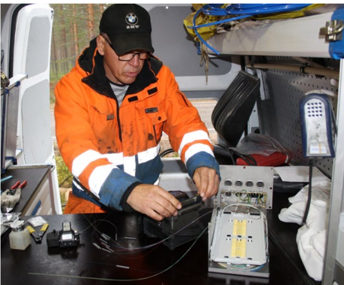
Kuva 8.4. Valokuidun jatkamista maastossa (Kuvat: Nestor Cables Oy).
