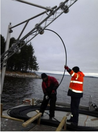
Kuva 7.29. Vesistökaapelin asennusta järveen (Kuvat Relacom Oy)
