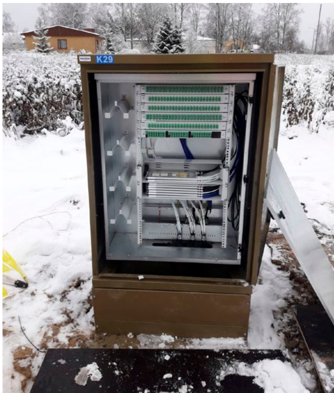
Kuva 6.8. Jaottimia sijoitettuna ulkoristykenttäkaappiin (Kuva: Televerkkopalvelut Seppo Marttila Oy).
