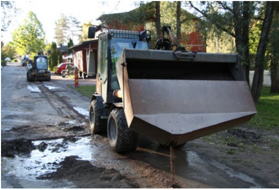
Kuva 7.20. Mikro-ojitusta pientaloalueella (Kuvat Nestor Cables)
