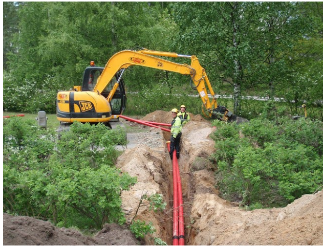
Kuva 7.5. Kanavaputkiston asennusta (Kuva: Veljekset Toivanen Oy).
