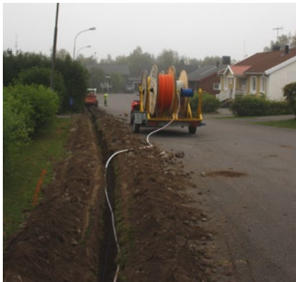
Kuva 7.21. Kaapeliuran jyrshintä sekä mikrokanavaputkien asennusta (Kuvat: Nestor Cables Oy).
