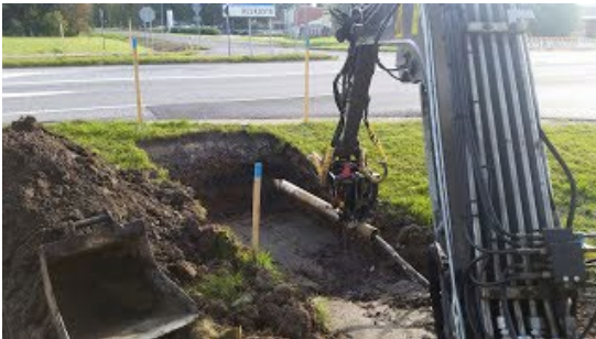
Kuva 7.24. Esimerkkejä tunkkauksesta ja suuntaporauksesta (Kuvat Suomen Alitustekniikka Oy)
