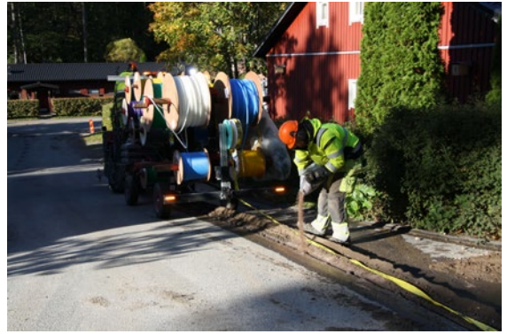
Kuva 7.20. Mikro-ojitusta pientaloalueella (Kuvat Nestor Cables)
