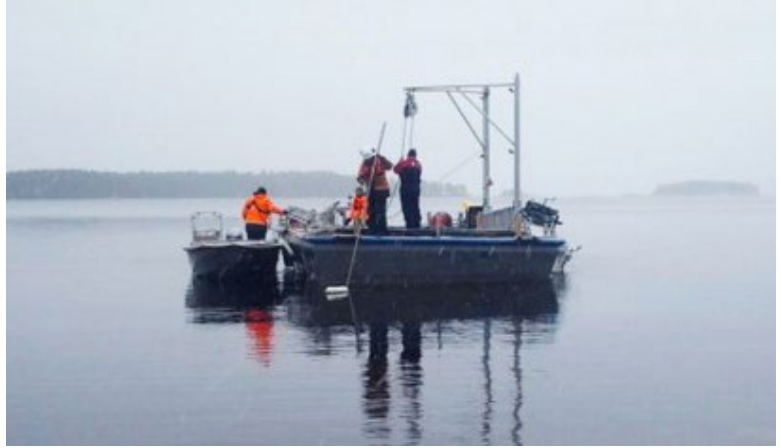
Kuva 7.29. Vesistökaapelin asennusta järveen (Kuvat Relacom Oy)
