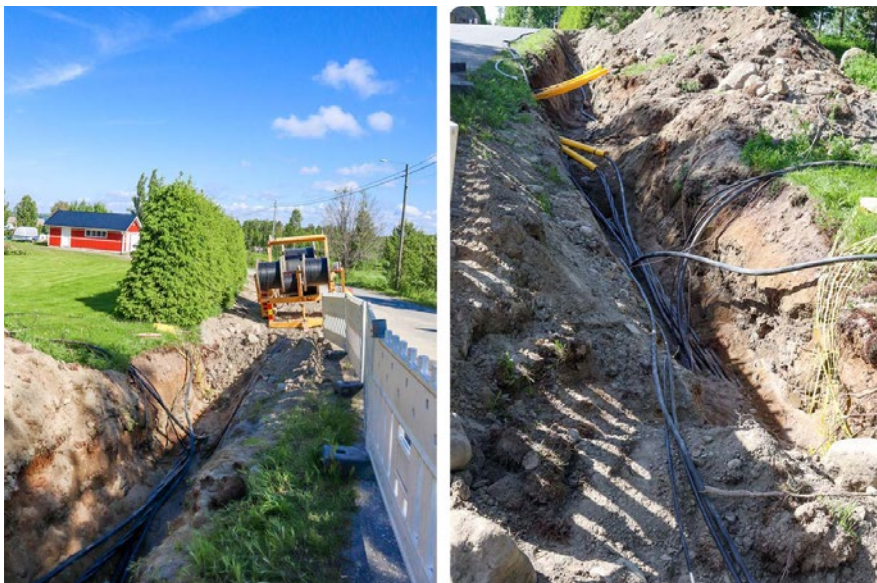
Kuva 7.23. Sähkö- ja valokaapeleita samassa kaivannossa (Kuva Nestor Cables Oy)
