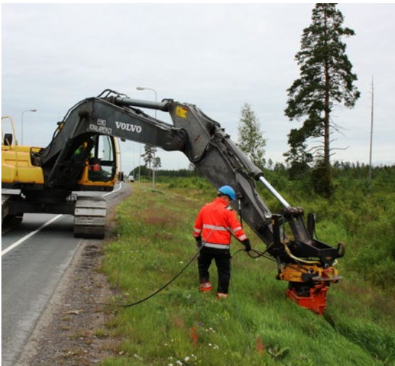
Kuva 7.17. Kaapeleiden aurausta (Kuvat: Nestor Cables Oy).
