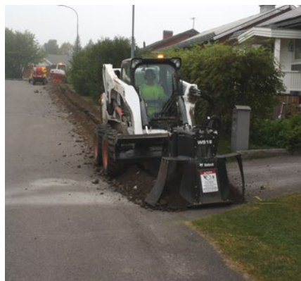
Kuva 7.21. Kaapeliuran jyrshintä sekä mikrokanavaputkien asennusta (Kuvat: Nestor Cables Oy).
