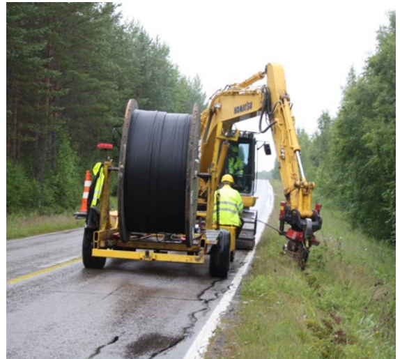
Kuva 7.17. Kaapeleiden aurausta (Kuvat: Nestor Cables Oy).
