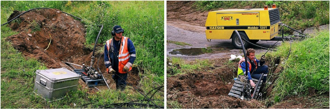
Kuva 7.7. Kaapelin asentamista putkeen puhaltamalla (Kuvat: Nestor Cables Oy).
