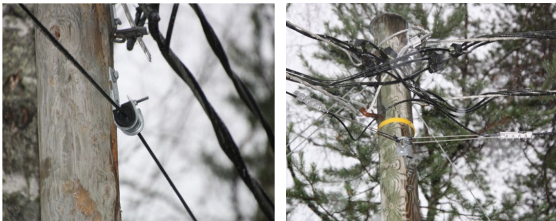
Kuva 7.26. Metalliton itsekantava (ADSS) ilmakaapeli asennettuna (Kuvat: Nestor Cables Oy).
